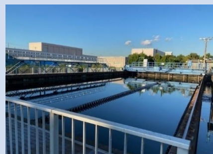
浄化センター整備事業
