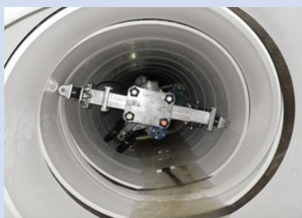
管渠改築事業
