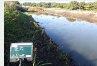
▼生実川（施工後）
