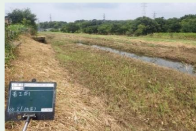
▼生実川（施工前）
