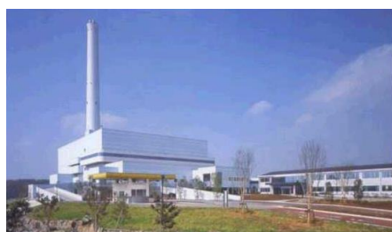
新清掃工場と北清掃工場の整備
