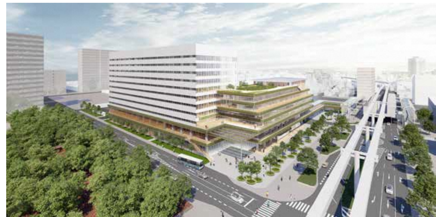
敷地南側より
