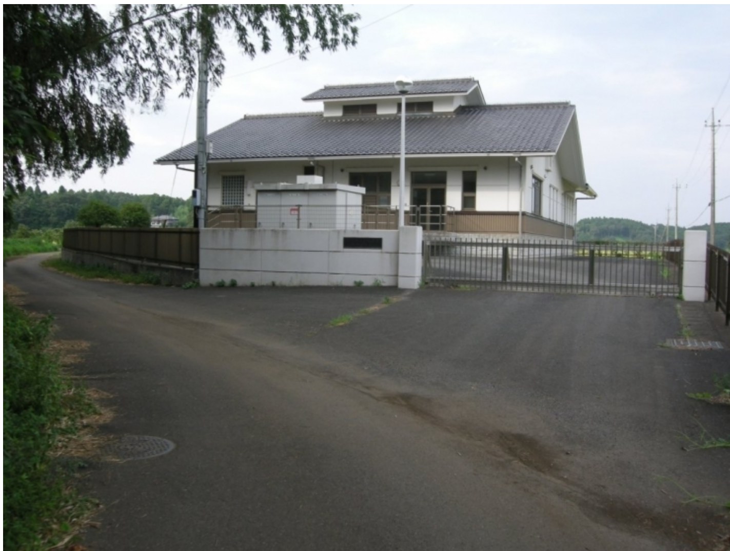
この白い建物は、「農業集落排水事業 中田古泉処理場」（排水処理施設）である。
