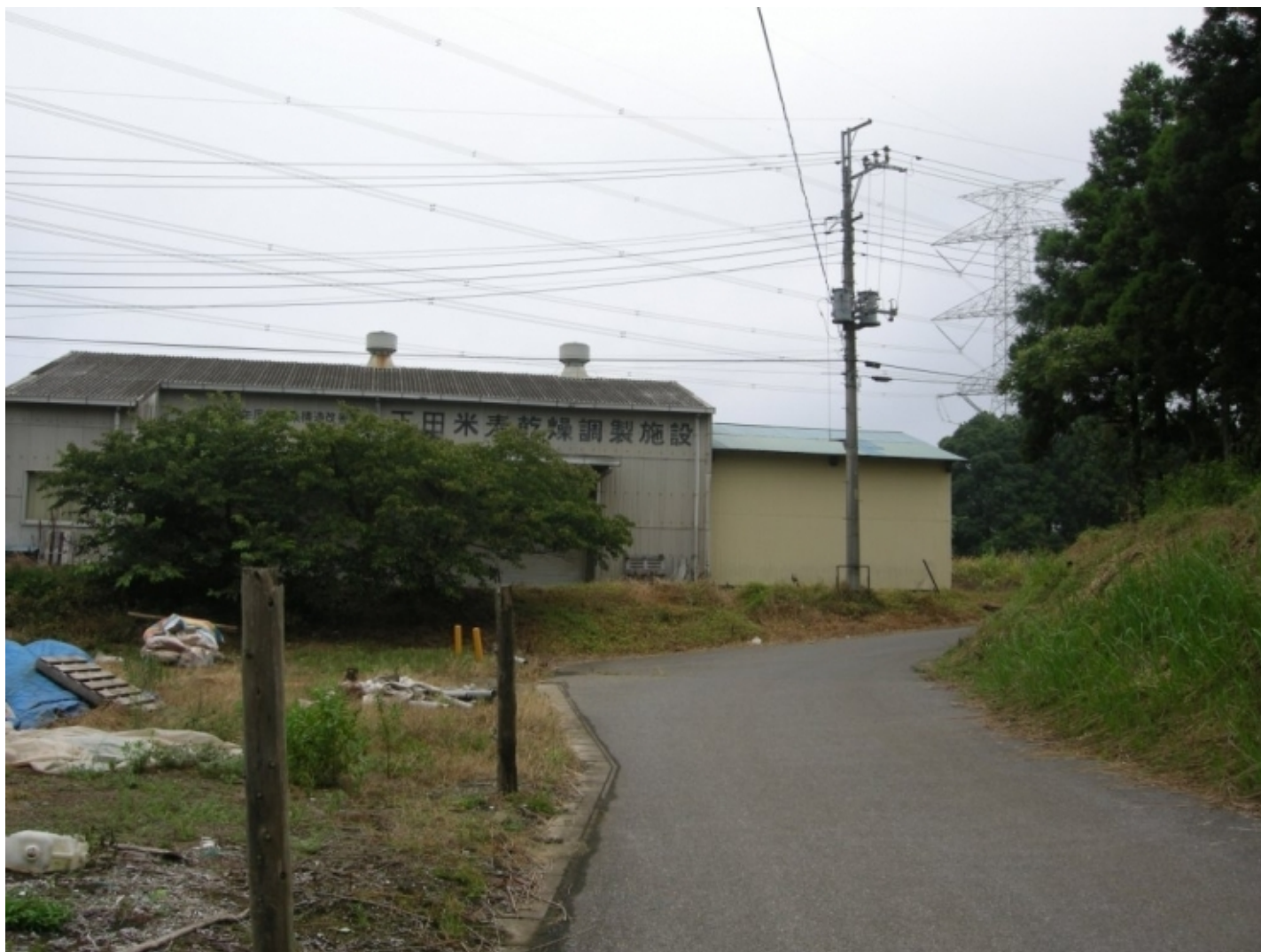
左折すると前方に「下田米麦乾燥調整施設」が見える。道なりに右に折れて進む。
