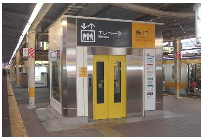
(駅舎内のエレベーター設置)
