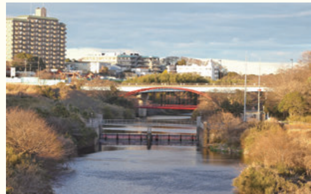
天戸制水門・水道橋・花見川大橋
