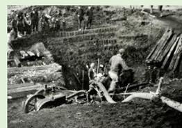
発掘現場：泥炭地で崩れやすいので土留めをして掘削している
