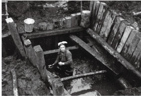
泥炭地は崩れやすいので土留めをして掘削する
