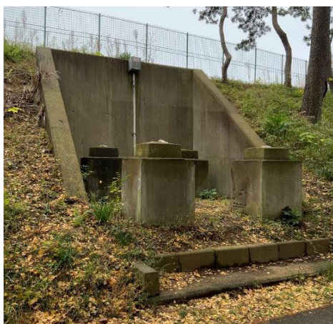
22照明塔基礎, 23コンクリート擁壁-2
