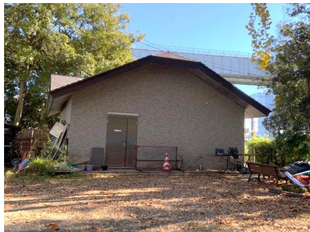
39災害応急対策施設
