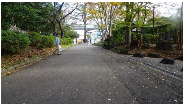
69アスファルト舗装, 71コンクリート縁石
