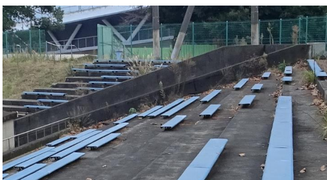
62コンクリート擁壁-5
