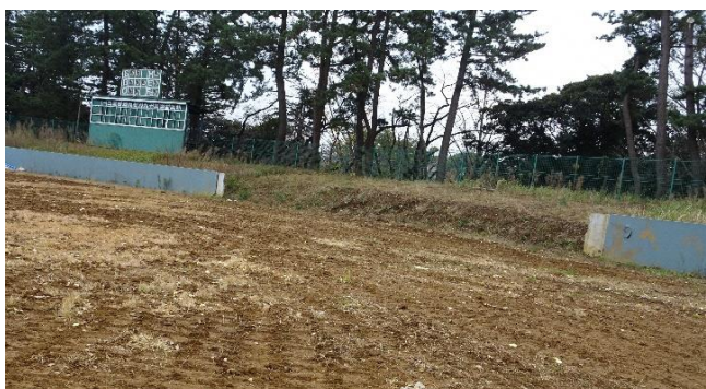
57コンクリート擁壁-4, 58コンクリート擁壁-5
