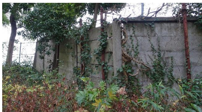
24コンクリートウォール-1
