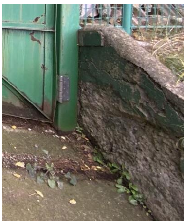
51コンクリート擁壁-3
