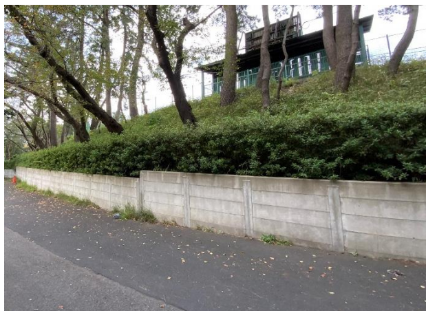
21コンクリート擁壁-1
