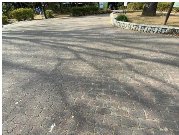
70ブロック舗装
