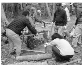
要となる杭を打ち込みます
