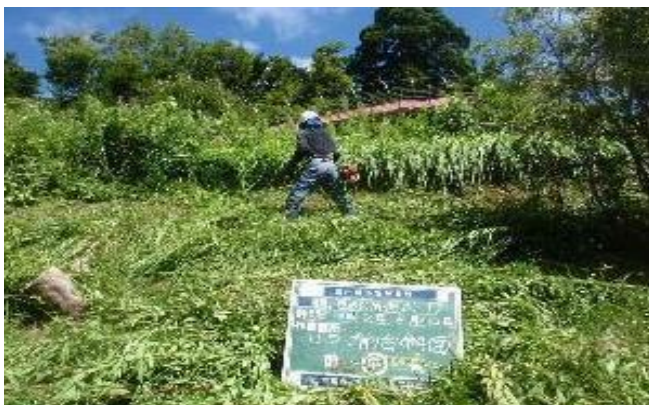
園地管理工 ⑨草刈(肩掛け式)ー1 ローラーすべり台斜面 作業前
