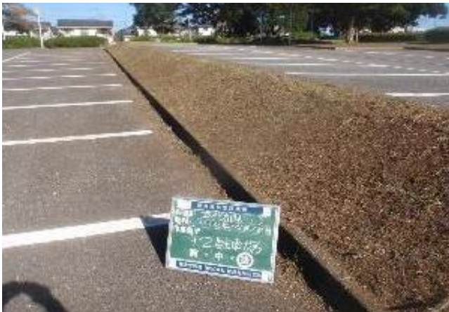
園地管理工 ⑬芝刈(肩掛式) 第2駐車場 作業後
