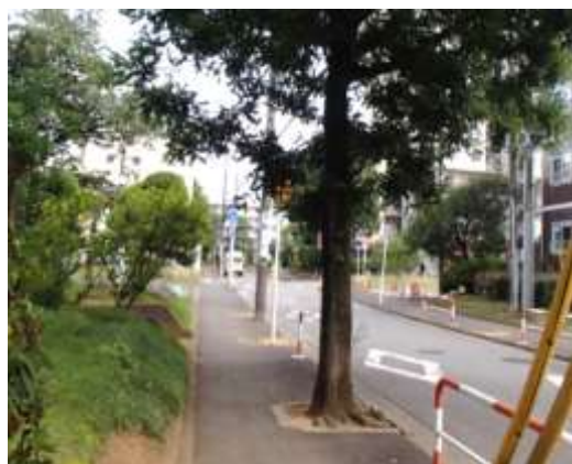
歩道の有効幅員が確保されていない路線
