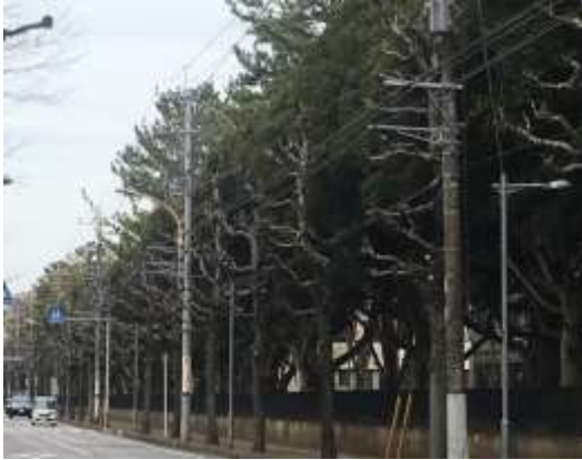
電線と樹木が交錯している路線
