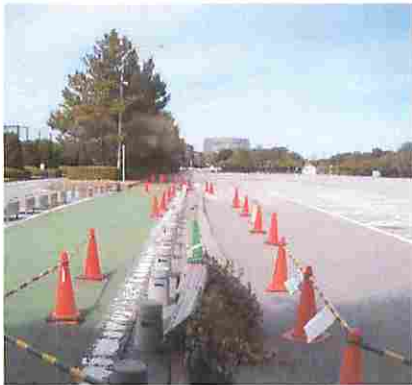
稲毛海浜公園 第1駐車場 危険箇所にはカラーコーン等で 立ち入りを制限
