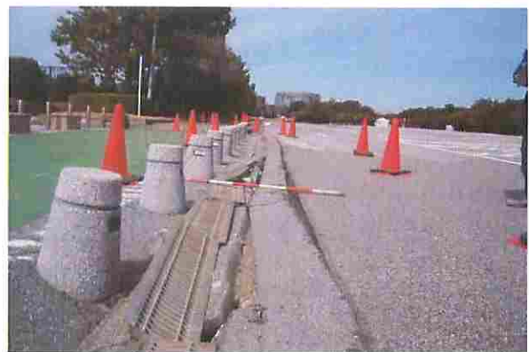
稲毛海浜公園第1駐車場
