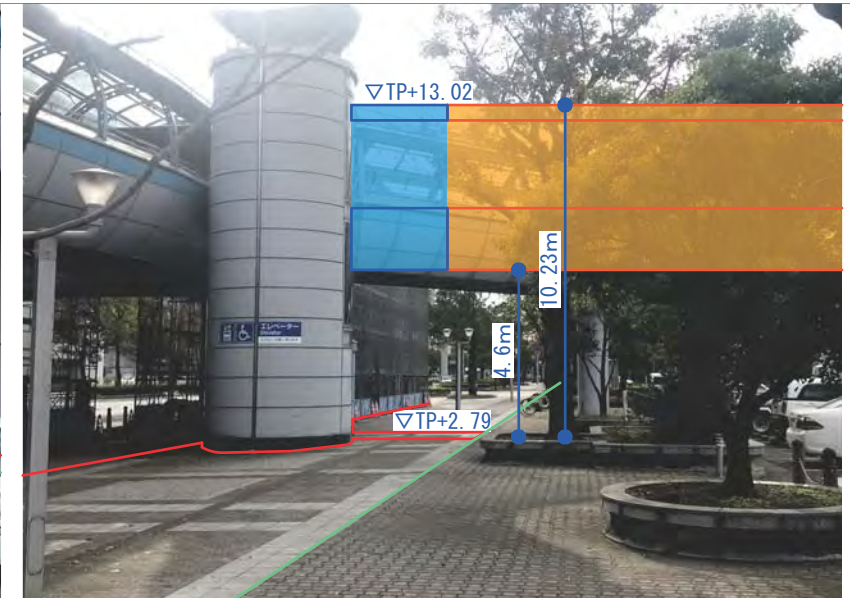
C写真：敷地東側より撮影、既存および周辺状況
