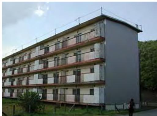
妻側の壁に外断熱工事を実施した例
