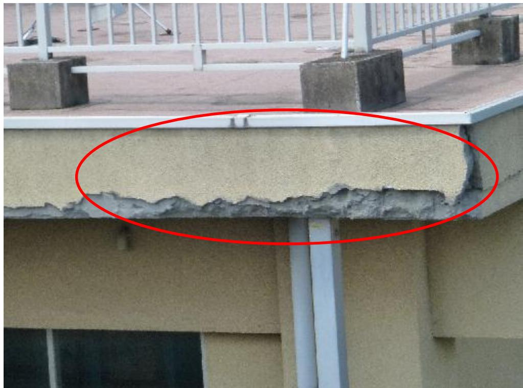
（川戸小学校校舎庇部分の外壁欠落写真。鉄筋の腐食を防ぐため、応急的な措置による補修を行っている。平成24年8月7日包括外部監査人補助者が撮影。）
