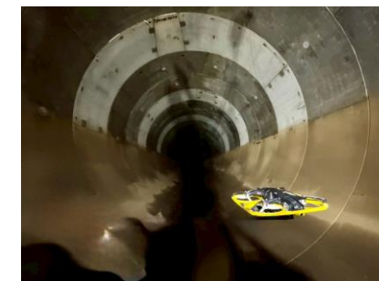
ドローン点検の様子
