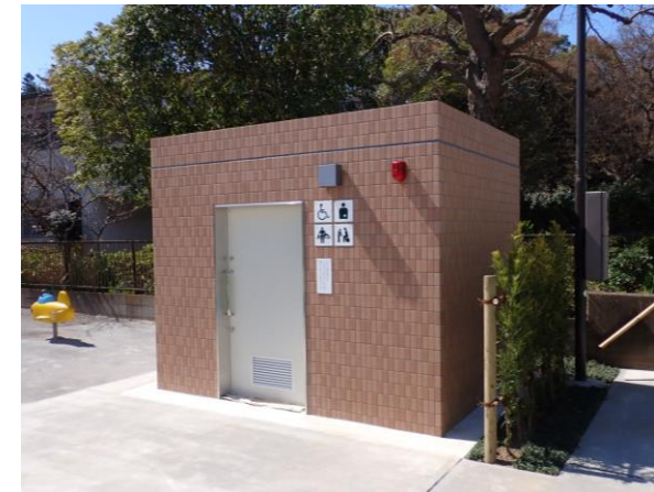
改修後の公園トイレ
