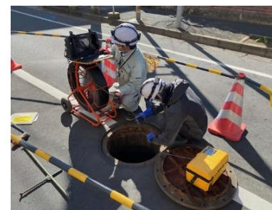
緊急点検の様子
