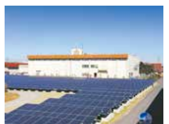
南部浄化センターの 太陽光発電設備（建設中）
