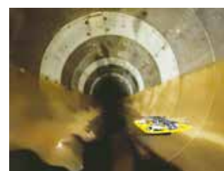
下水道管内を点検する ドローン
