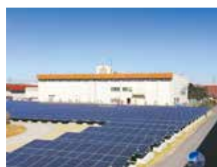
南部浄化センターの 太陽光発電設備（建設中）
