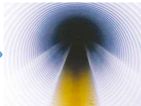
対策 内側に帯状のプラスチックを巻き立て修理した下水道管
