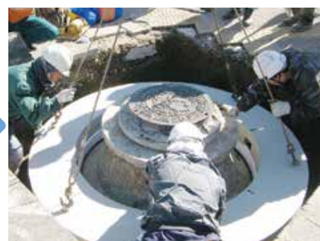
対策 マンホールの耐震工事
