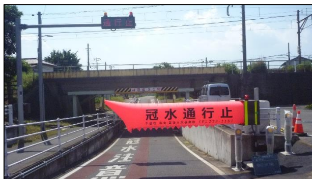
エアー遮断機(村田町 JR 内房線地下道)
