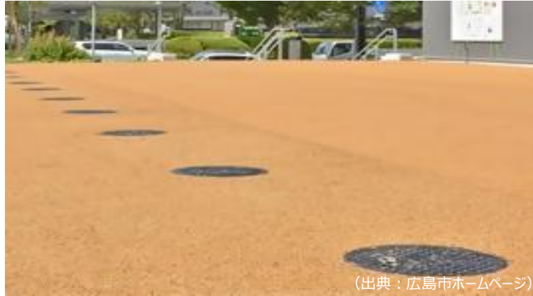
【参考イメージ2】ひろしまスタジアムパークに整備されたマンホールトイレ
