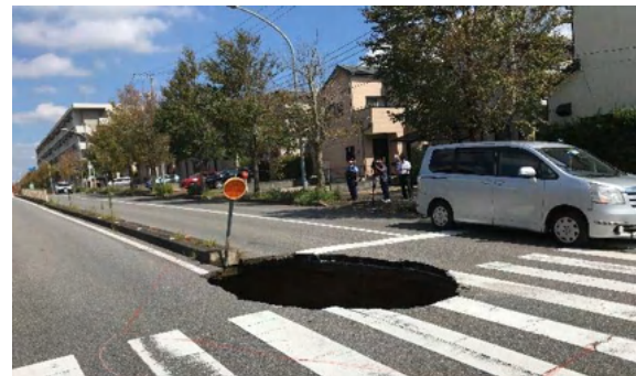
R 元 老朽化した管渠の損傷による道路陥没事故（緑区あすみが丘）
