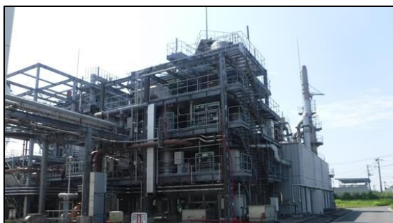
既存の汚泥焼却炉（築28年と31年）
