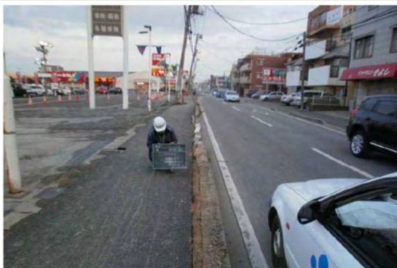
電柱倒壊状況（東日本大震災）
