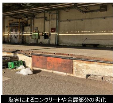
<【図表Ⅲ-5】老朽箇所の例>
