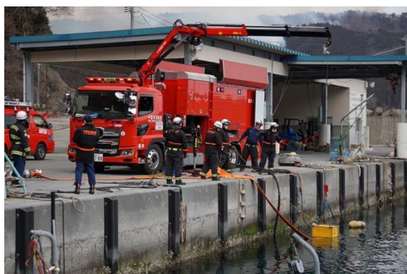
3月4日 遠距離大量送水小隊による送水の様子 （大明神地区）
