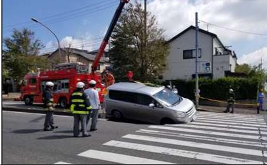
R元 老朽化した管渠の損傷による道路陥没事故（緑区あすみが丘）
