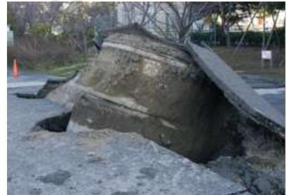
液状化でマンホールが飛び出した道路（船橋市）
