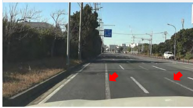
写真票：岸1線 海浜大通り
