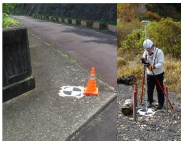
① 標定点の設置・測量
