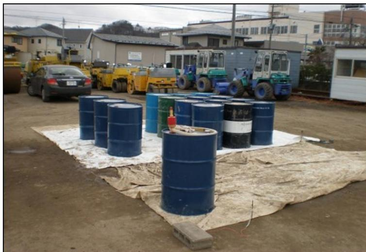
【ドラム缶による燃料の一時的な貯蔵例】
