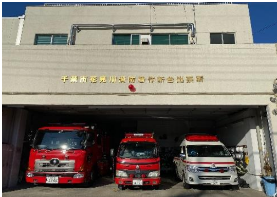
【花見川消防署作新台出張所】 千葉市花見川区作新台 1-2-1
