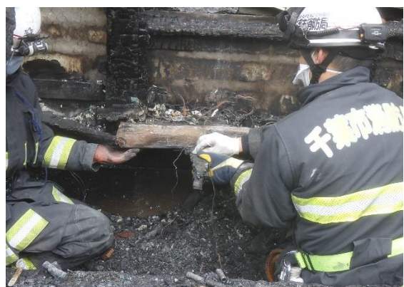
【火災原因調査（実況見分）】
