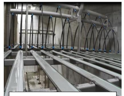
膜ブレン式散気装置
