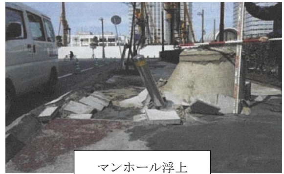
図2-10 管渠の被害状況
