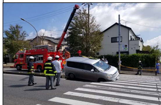
R 元 老朽化した管渠の損傷による 道路陥没事故 (緑区あすみが丘)
