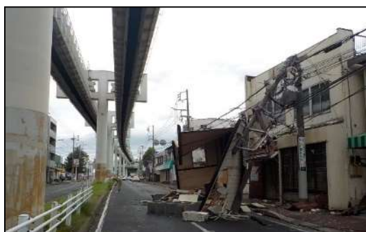
R 元 台風 15 号による電柱倒壊状況
