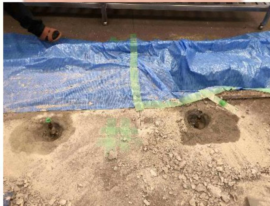
給食室の水道管が老朽化のため、破裂してしまいました。給食が早く復活できるように、急いで修理をしています。
