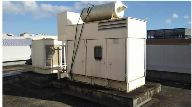
ロープにて固定し処置 (台風16号通過時も問題なし)
