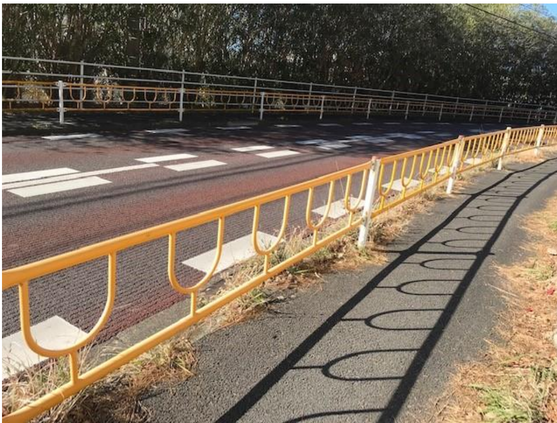
歩道安全柵① （当日中の現状復旧を条件に、一時的な取り外し可）
