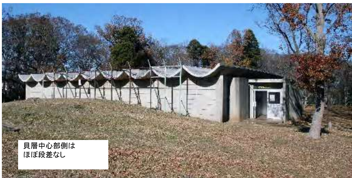
施設外観 南東から
