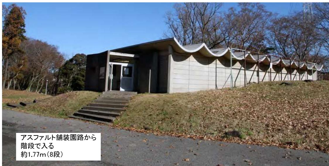
施設外観 南西から
