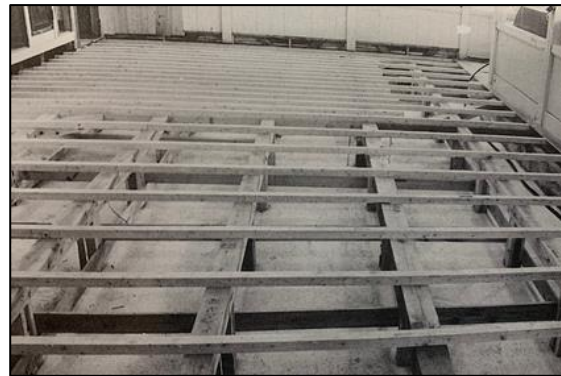
事務室の床組み再設置
