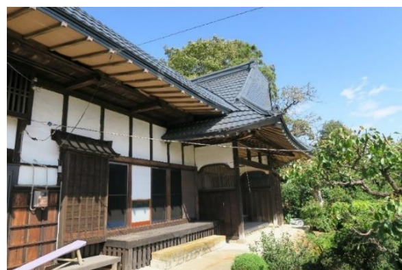
現況写真2 建物正面
