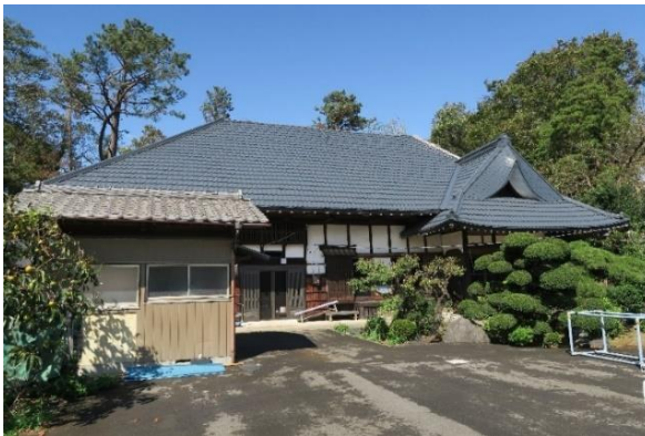
現況写真1 建物正面
