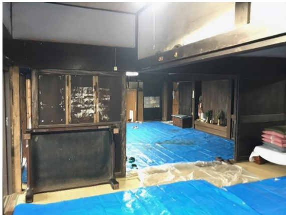
現況写真3 差鴨居
