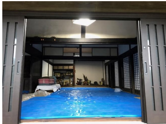
現況写真4 差鴨居
