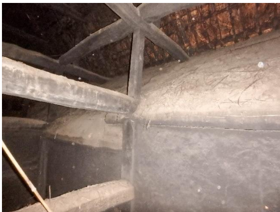
現況写真5 旧天井上端
