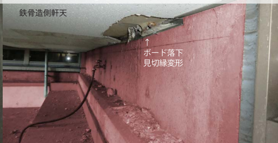
D 軒天（鉄骨造建物側）と保存建物の接する部分で破損
