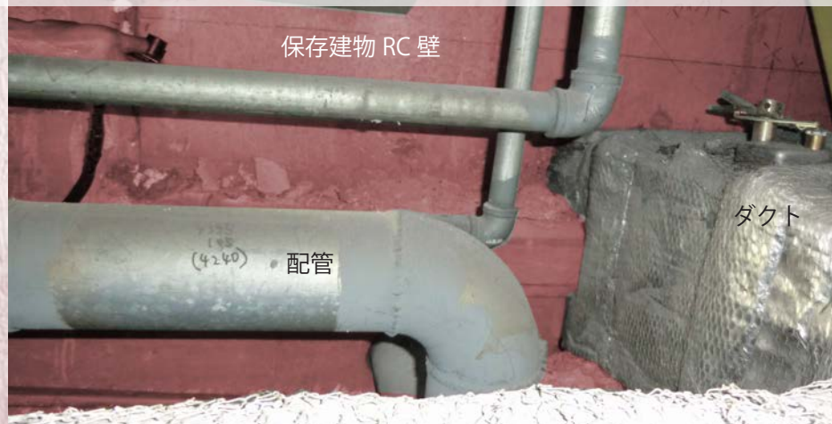
D 軒天（鉄骨造建物側）と保存建物の接する部分で破損
