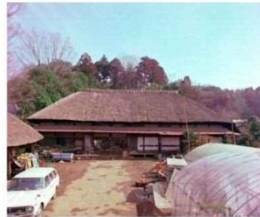
旧四間家（解体保存中）
