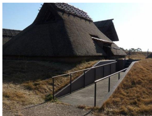
復元建物に設置されたスロープ
