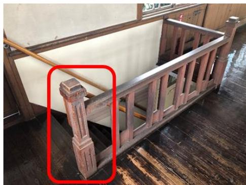
親柱と床の隙間に木製のくさびを打ち込み固定。
