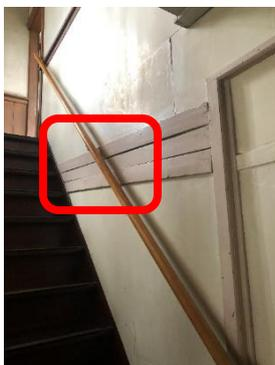
手摺が設置された板を、壁(ベニヤ板)内側の基礎柱にビスで固定。
