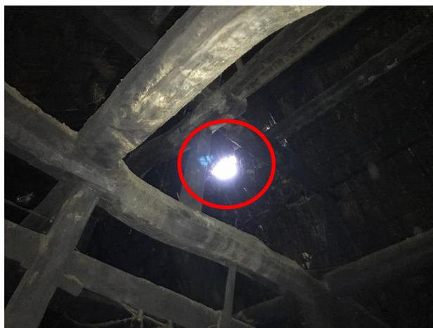
写真2 破損箇所現況(屋根裏)
