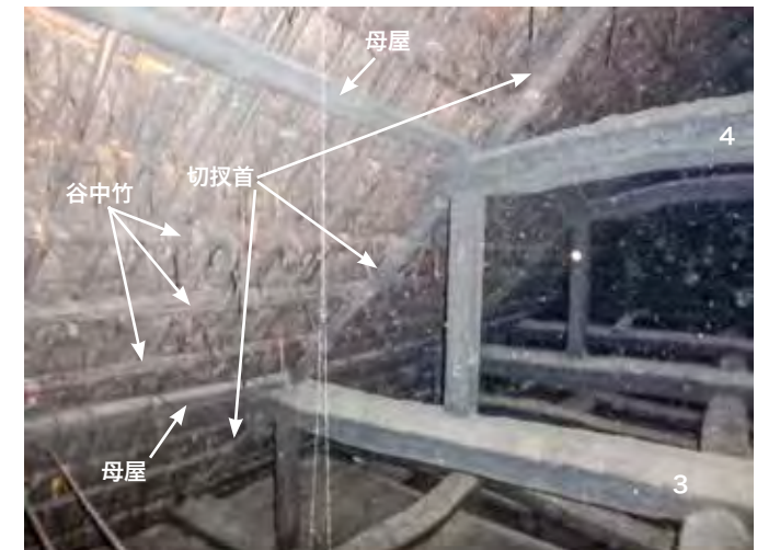
切叔首・母屋・谷中竹・垂木竹 にわば・厨子二階上部 南西
