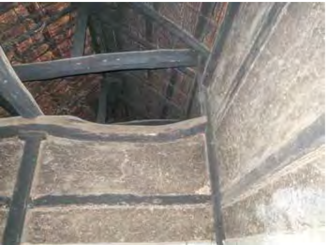
天井裏の壁 東側 なんど側
