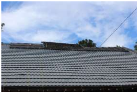
写真4 建物正面現況（詳細）
