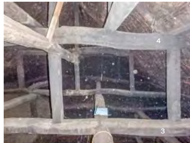
3重梁・4重梁 ざしき上部 東側
