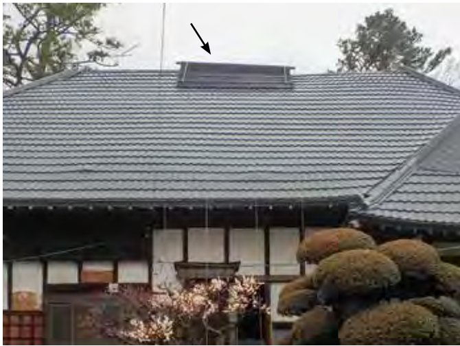
正面屋根 旧煙出し応急処置
