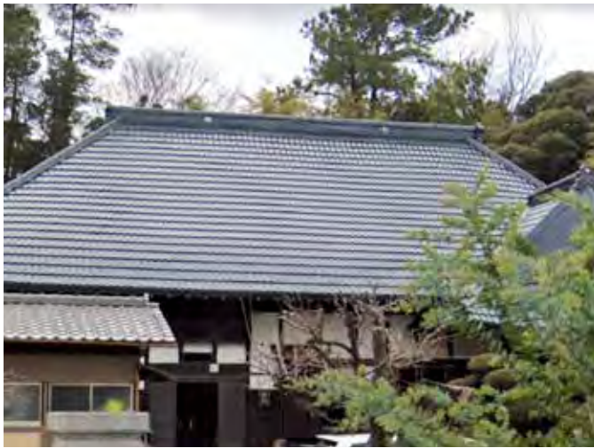
台風罹災前の正面屋根 Google マップ https://www.google.co.jp/ より 金属瓦施工時に旧煙出しを撤去し、旧煙出し部分を平葺きで覆ったうえ、大棟全体に箱棟が掛けられた。
