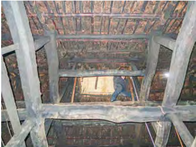
旧煙出し部分 見上げ
