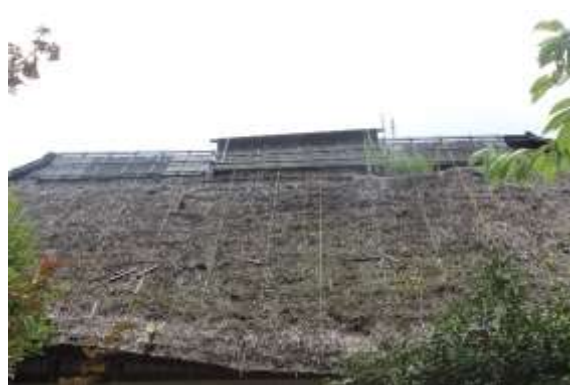
写真5 建物裏面現況
