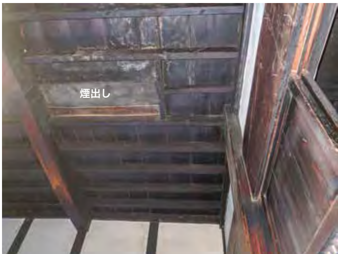
根太天井 囲炉裏の煙出し
