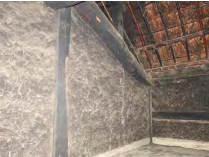
天井裏の壁 西側 へや側
