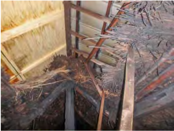
旧煙出し跡 左：背面側 右：正面側
