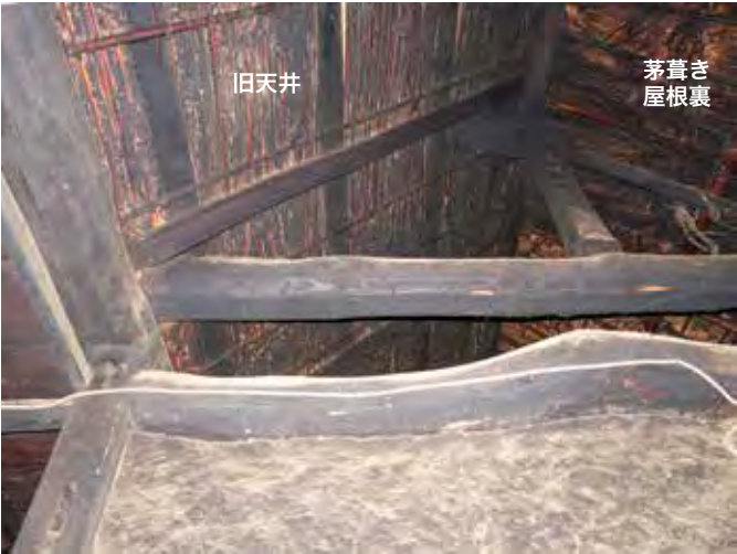
上部の旧天井 東側 なんど側
