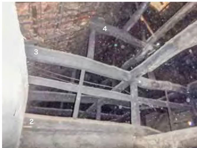
2重梁・3重梁・4重梁 ざしき上部 西側
