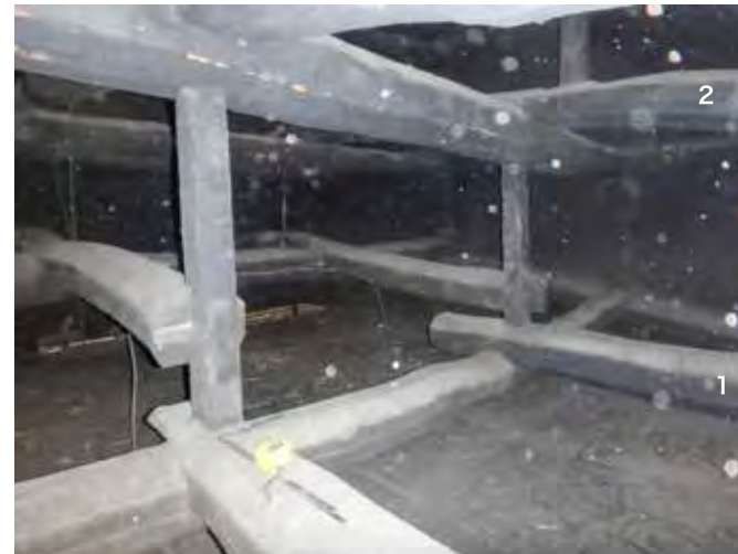
小屋梁・2重梁 ざしき上部 北東
