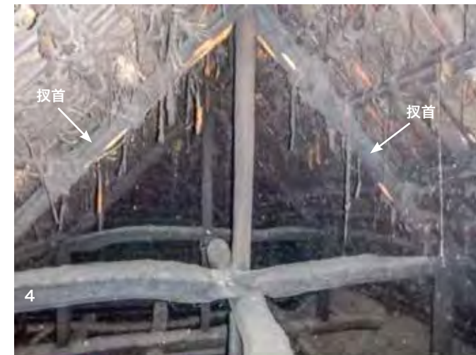
4重梁 棟束 にわば・厨子二階上部 西側
