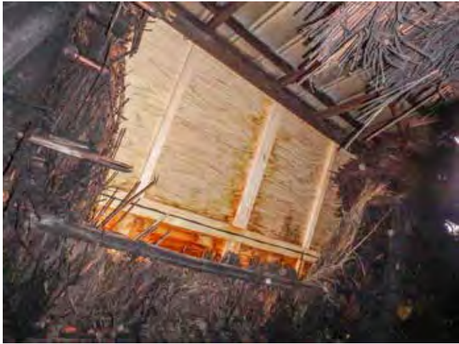
旧煙出し跡 背面側
