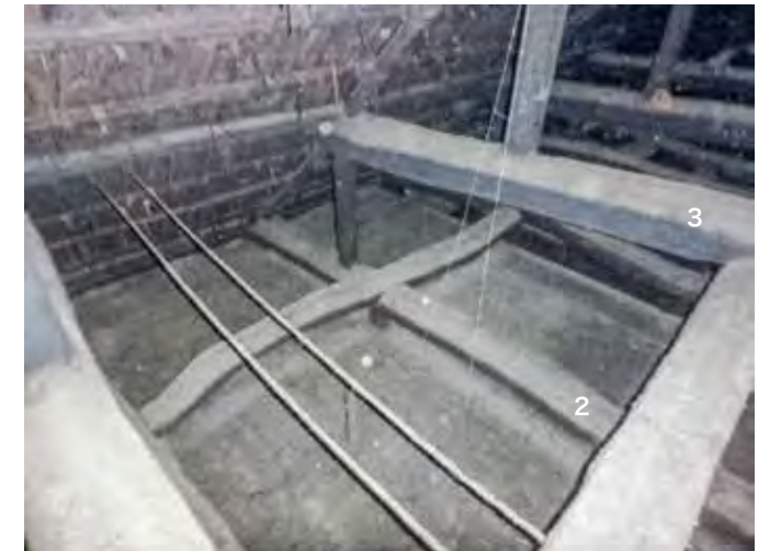
2重梁・3重梁 にわば・厨子二階上部 南西 厨子二階の天井裏。にわば上部に厨子二階の床梁が掛けられており、小屋梁はない。
