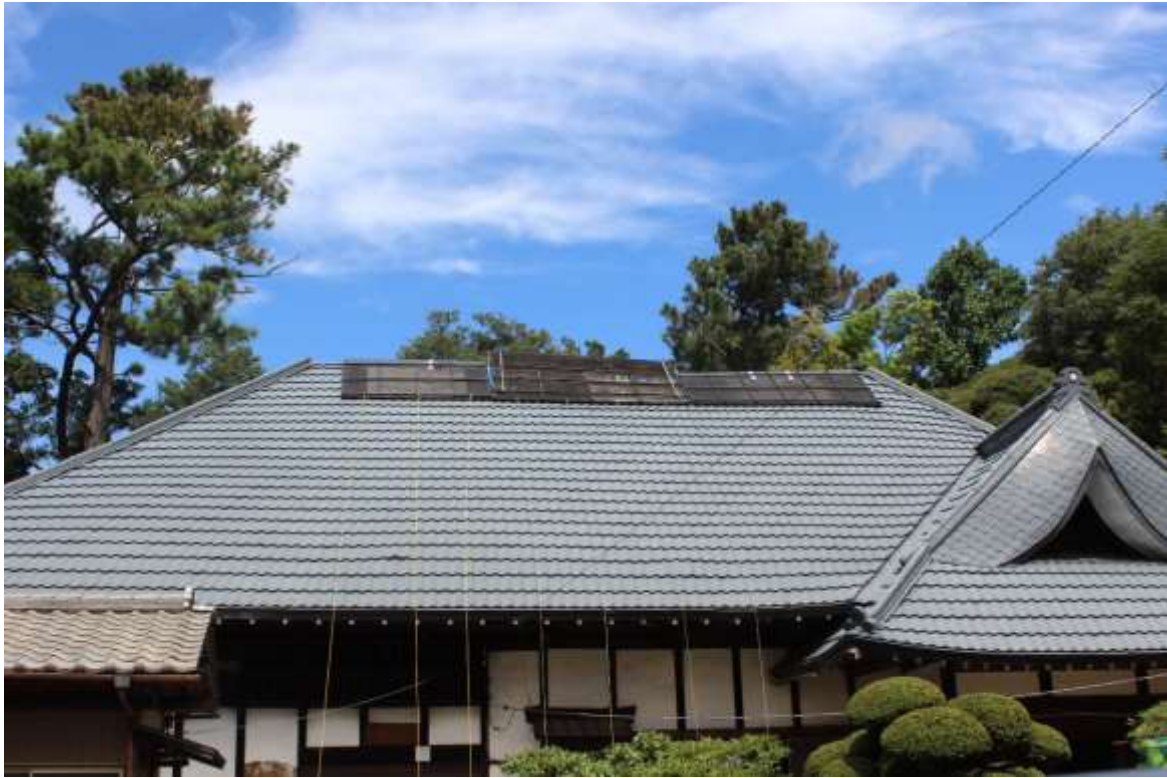
写真3 建物正面現況
