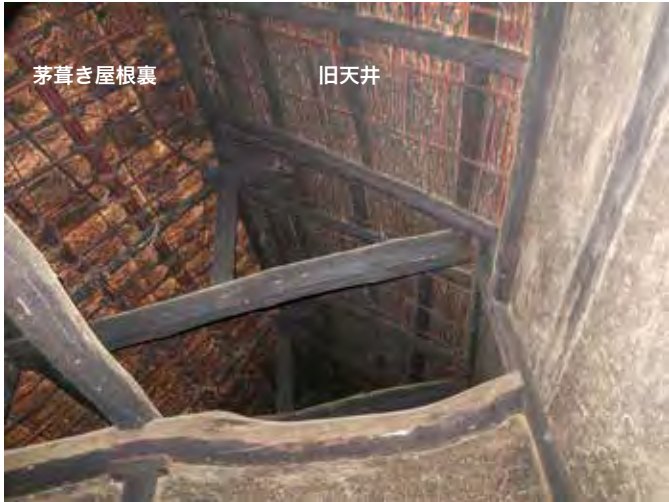
上部の旧天井 西側 へや側
