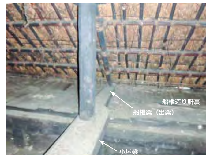
小屋梁 (出梁) 船柵造り部分 小屋梁の端部が出梁として延び、船柵梁となっている。
