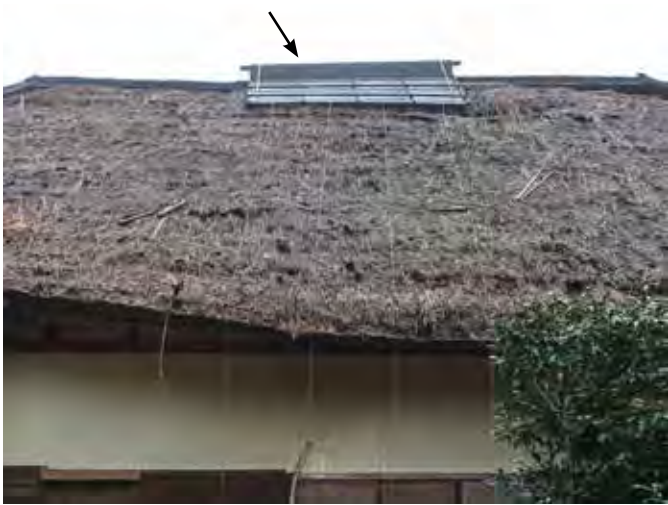
背面屋根 旧煙出し応急処置
