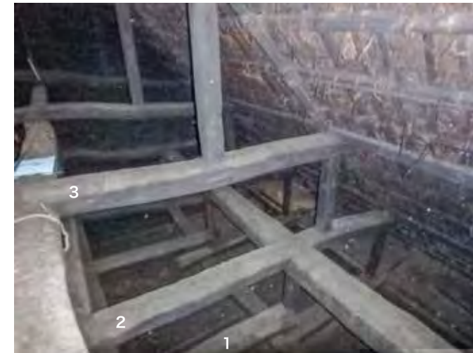
小屋梁・2重梁・3重梁 ざしき上部 南東
