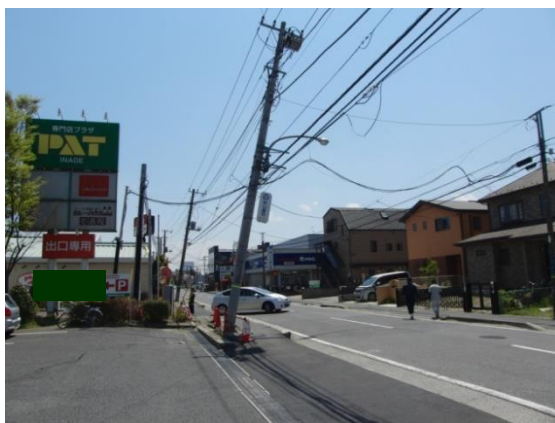
液状化により傾いた電柱（美浜区）
