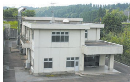
污水ポンプ場
