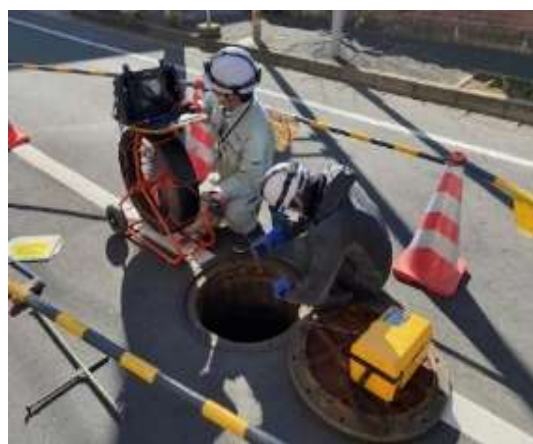
管口カメラによる点検
