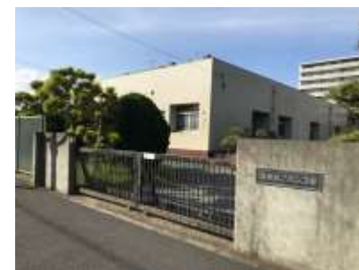
高洲第2ポンプ場 昭和48年10月運用開始
